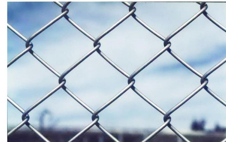
Photo 142 : grillage simple torsion en acier galvanisé brut
